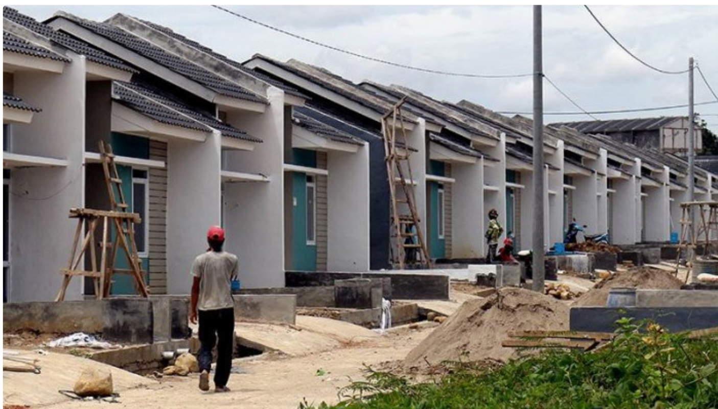
Pembangunan rumah subsidi di Citeurep, Kabupaten Bogor, Jawa Barat
